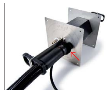
4. Installation du manchon isolant
